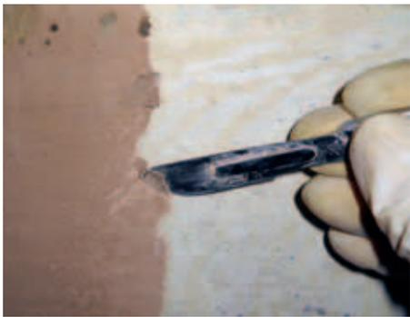
Rimozione del primo e del secondo strato con bisturi
