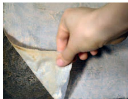
*Rimozione dell'impacco di resina a scambio ionico*
